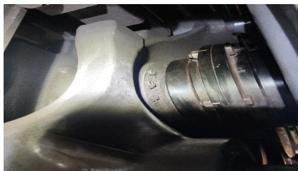
Рис. 3. Люфт выходного вала от тягового редуктора к муфте.
