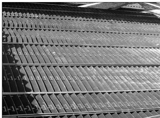
**Рис. 2.** Реконструкция отстойников КОС С.-Петербурга, секция радиального отстойника с установленными тонкослойными полочными блоками (вид сверху)
