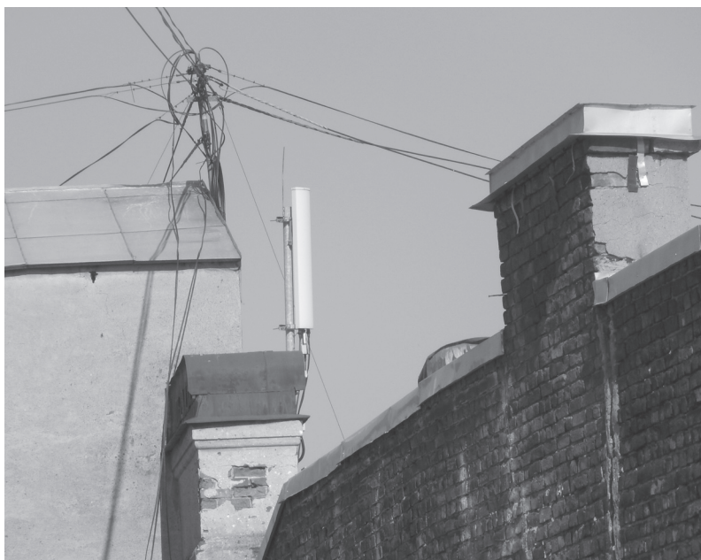
Рис. 3. Излучатель сотовой связи на крыше жилого дома
