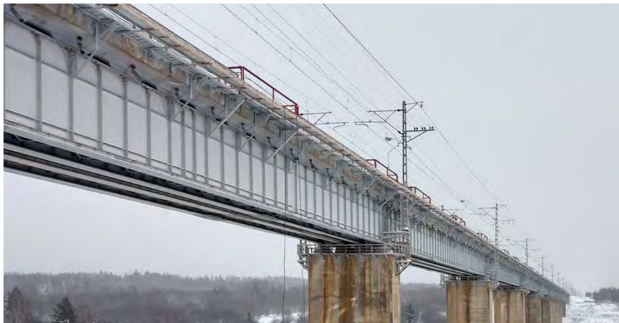
Рис. 1. Место проведения экспериментальных измерений — мостовой переход на линии Санкт-Петербург — Москва. Фотографии предоставлены автором
