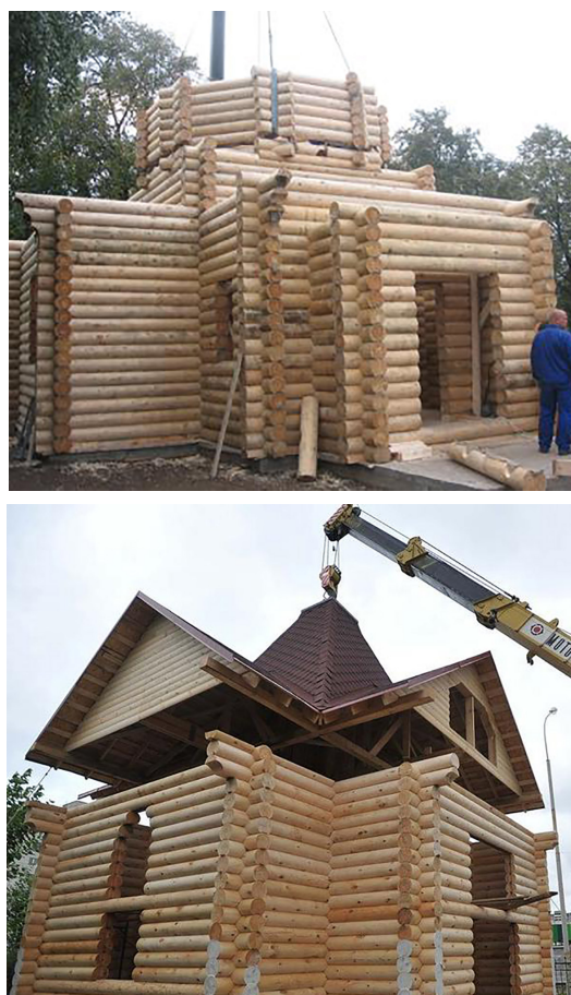
Рис. 14. Монтаж модулей быстровозводимых церквей 1
