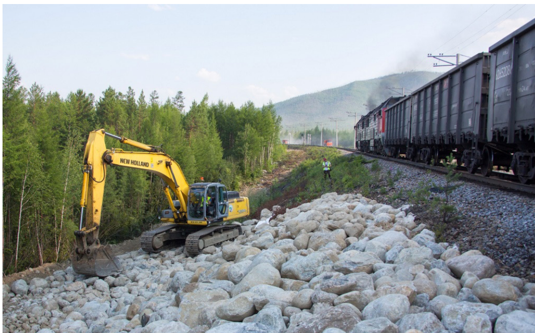
Рис. 7. Охлаждающая каменная наброска. Фото: https://bsmuk.ru/
