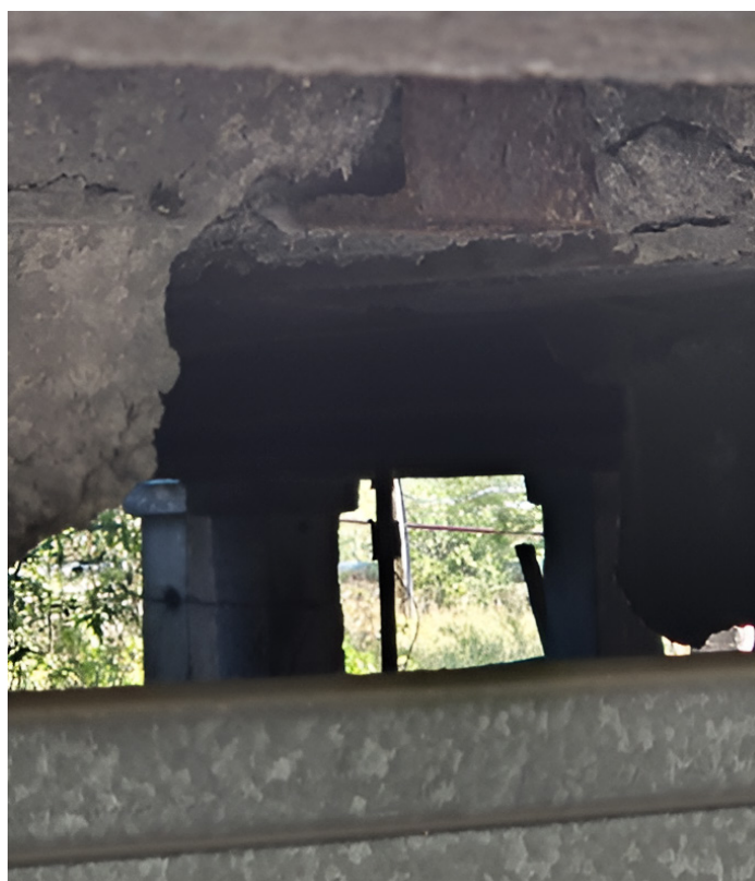
Рис. 5. Бетонные наливные сваи. Фото А. В. Святогоровой
