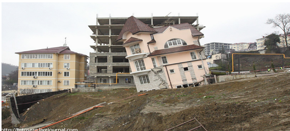
Рис. 6. Деформация жилого дома на порталном участке строительства автодорожных тоннелей № 8/8а Дублера Курортного проспекта в г. Сочи [8]
