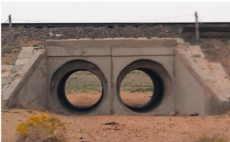
Рис. 3. Круглая сборная железобетонная труба с отверстием  $2 \times 1,25$  м на участке Нартын Хошуу — Шаргын Овоо Улан-Баторской железной дороги (фото Б. Жумагали)
