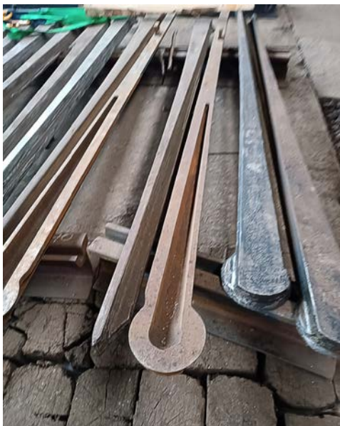
Рис. 4. Подвижный остряк (перо) стрелки (фото О. В. Вострикова)
