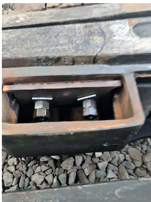
Рис. 5. Крепление пяты пера одноперьевой стрелки (фото О. В. Вострикова)
