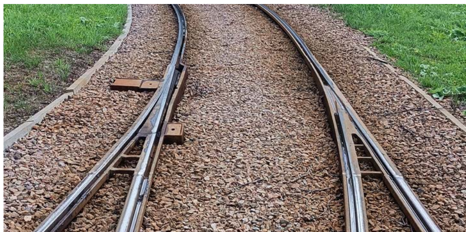
Рис. 2. Одноперьевой трамвайный стрелочный перевод в Санкт-Петербурге (фото О. В. Вострикова)
