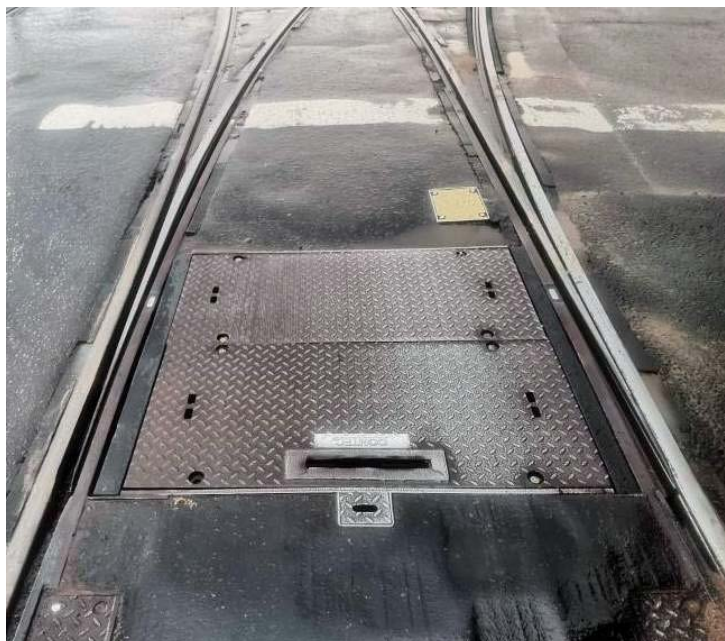
Рис. 8. Стрелочный перевод трамвая с гибкими перьями (фото О. В. Вострикова)
