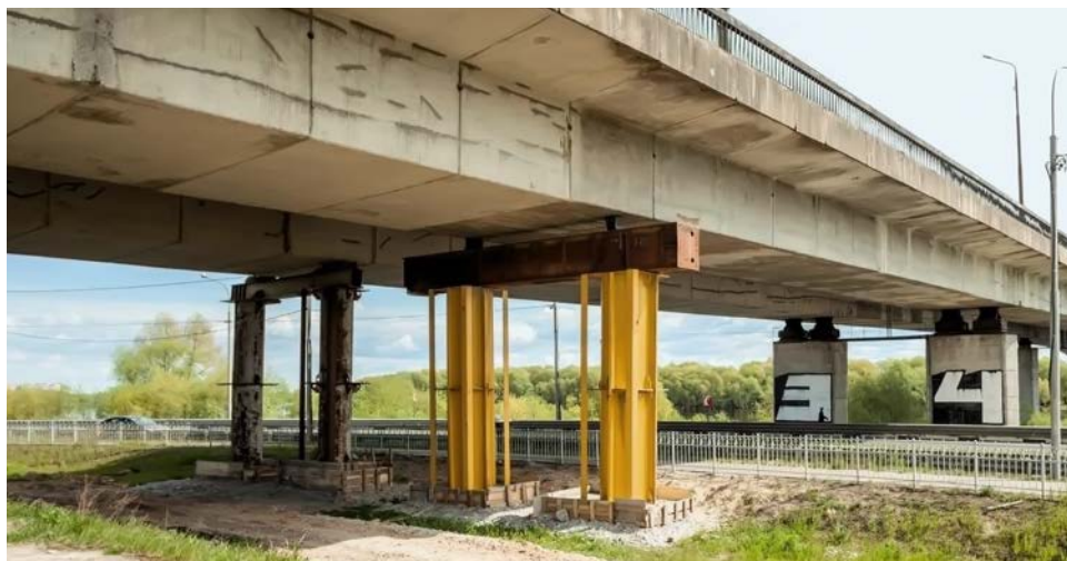
Рис. 1. Капитальный ремонт Колмовского моста в Великом Новгороде. Временная опора (фото МКУ «Управление капитального строительства»)
