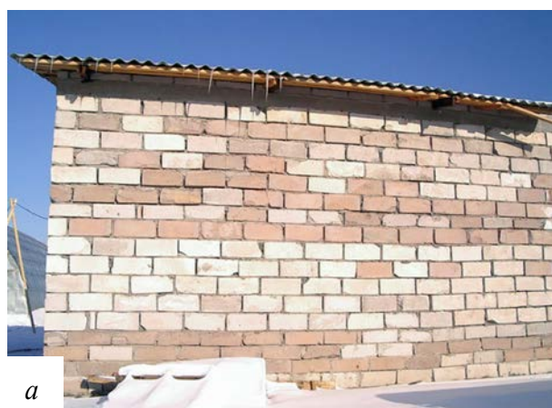
Рис. 4. Корпус промышленного здания (Предпортовая) из блоков автоклавного золопенобетона: а — 2005 год; б — 2024 год (фото Е. В. Русановой)
