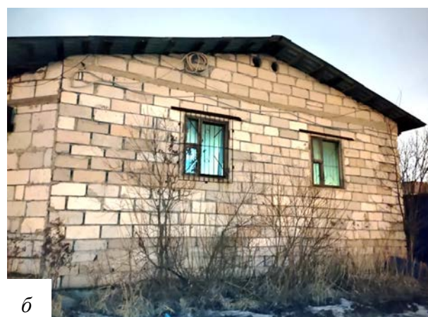
Рис. 4. Корпус промышленного здания (Предпортовая) из блоков автоклавного золопенобетона: а — 2005 год; б — 2024 год (фото Е. В. Русановой)
