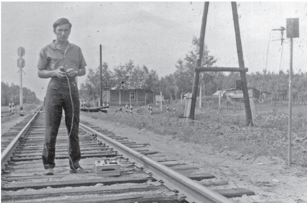
Рис. 4. Фонометрист за работой. Слева от него – фонометр, у ног – объективный шумомер
