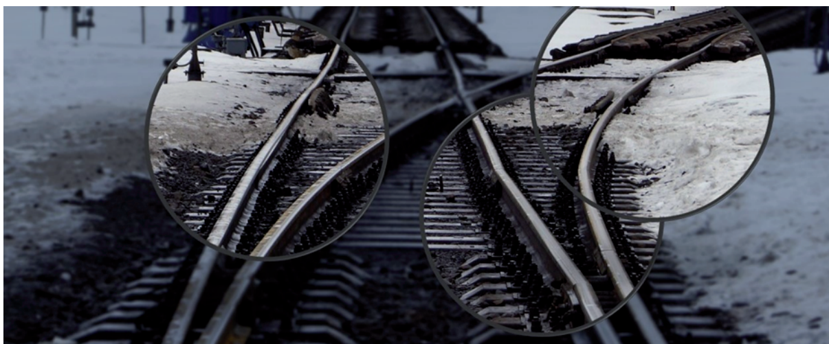
Рис. 2. Увод рельсовой колеи
