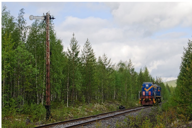
Рис. 2. Входной семафор на станцию Войта (недействующая)
