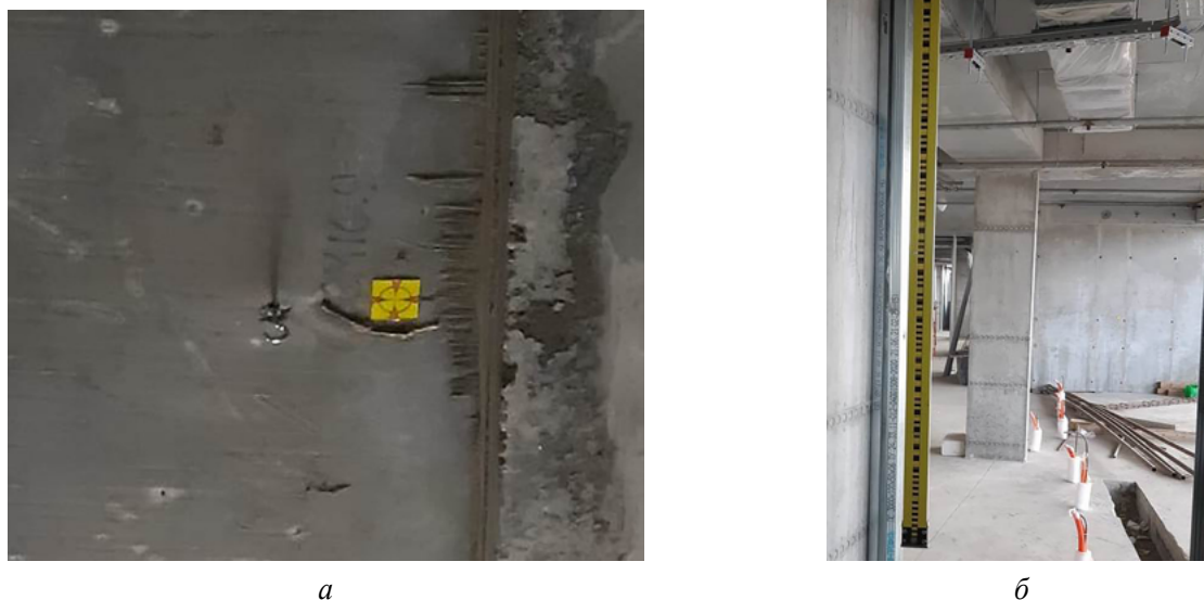
Рис. 2. Использование крючков в качестве осадочных марок: а — Общий вид; б — установка рейки для наблюдений
