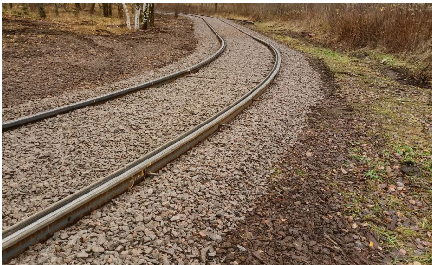
Рис. 6. Опытный участок экспериментальных трамвайных рельсов РТ62 категории прочности НТ300 на Петергофском шоссе, конечный пункт «ЛЭМЗ»
